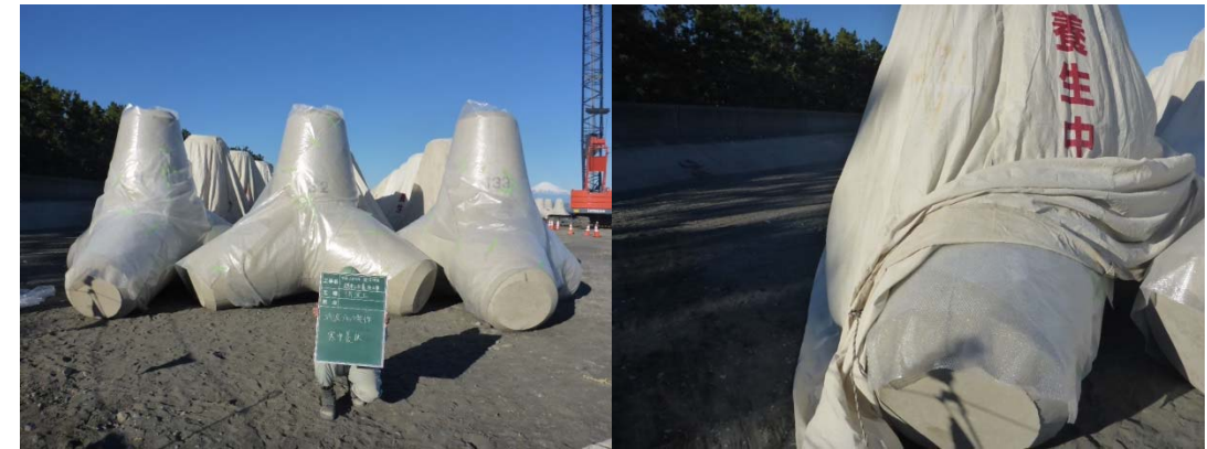
写真-14 外気と内部温度の差が4℃有り効果が期待できる
