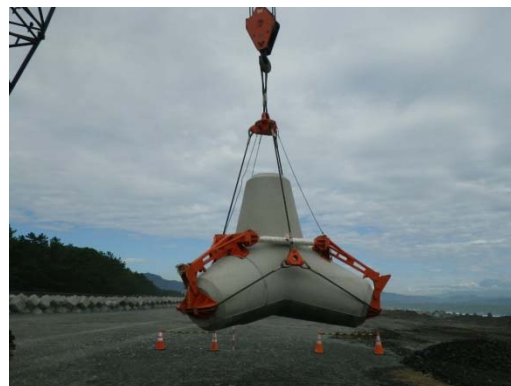
写真-12 サスペンダーによる転置
