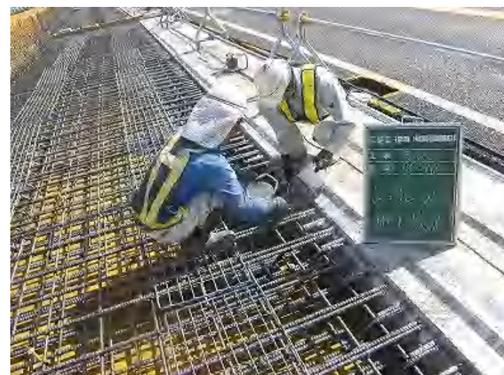
エポキシ樹脂系接着剤施工状況
