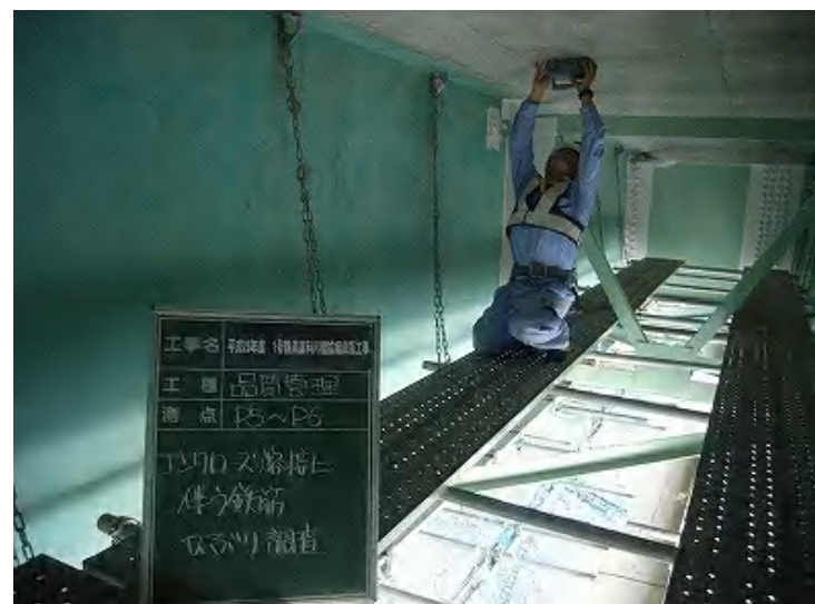
電磁波レーダー法による測定状況
